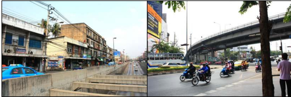
รูปที่ 5.4-6 อุโมงค์และสะพานข้ามทางแยกท่าพระ
