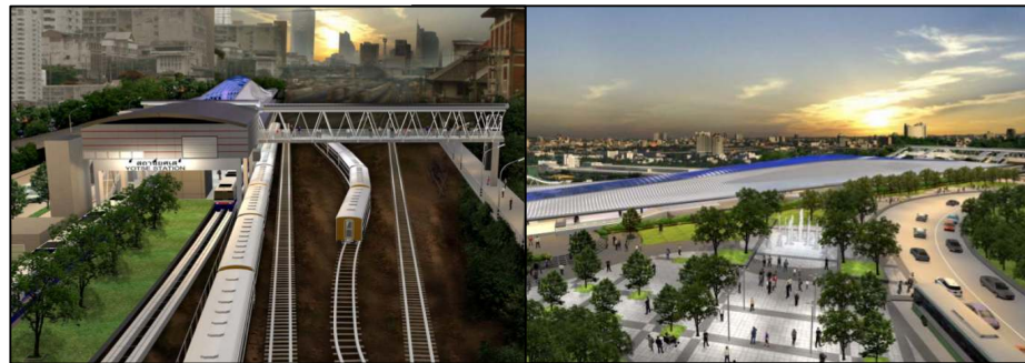
รูปที่ 5.3-3 รูปแบบรถไฟสายสีแดงช่วงบางซื่อ-หัวลำโพง บริเวณสถานียศเส (ซ้าย) และยมราช (ขวา)
